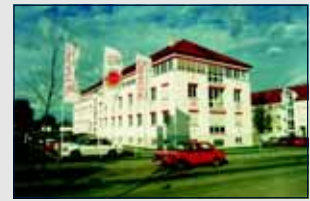
▲ Das erste Firmengebäude im Gewerbegebiet Coschütz/Gittersee ist heute Schulungszentrum und Sitz des Robotron-Supports
